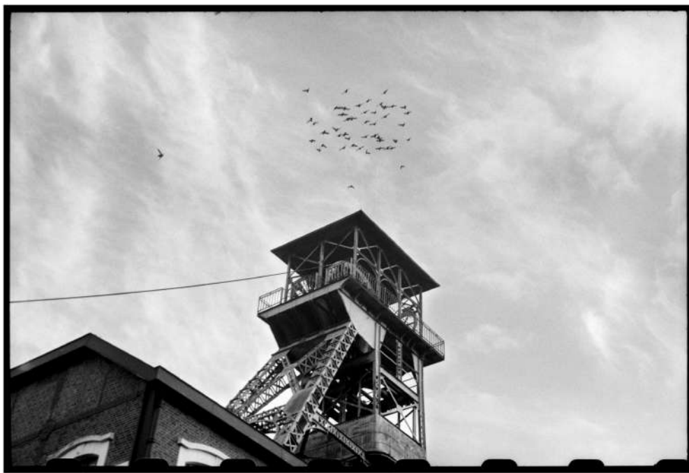
9 de Oignies. Le ciel est par dessus la mine.
