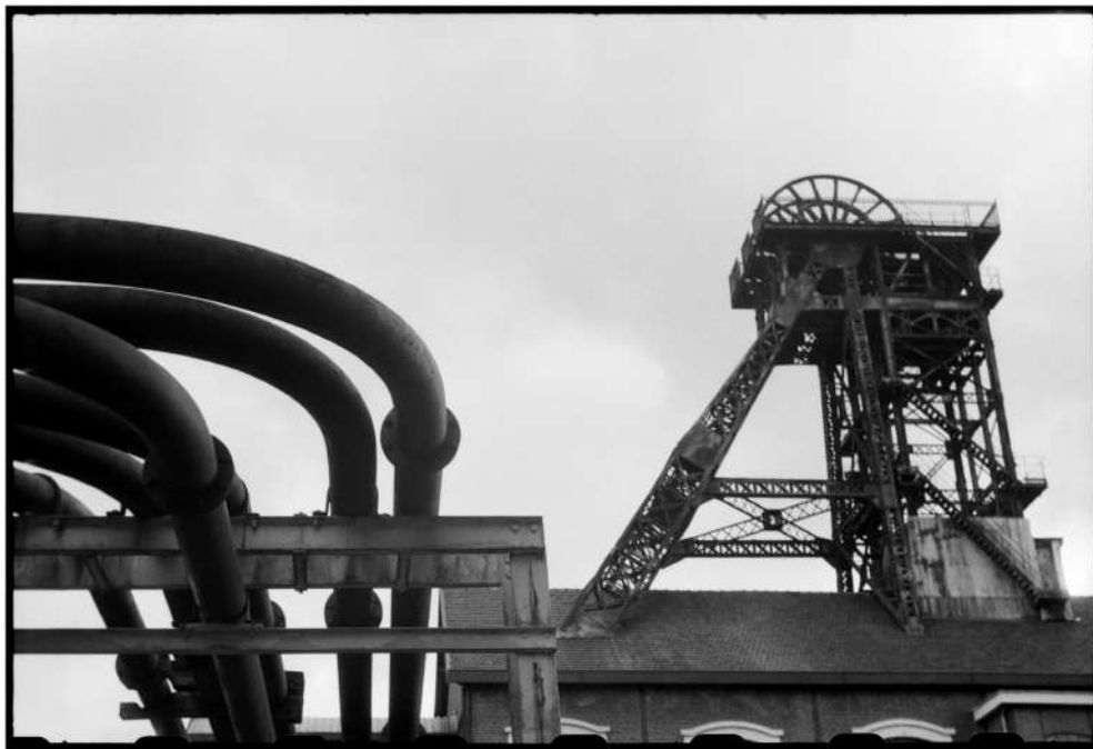
9 de Oignies. Canalisation d'air comprimé à destination du fond.
