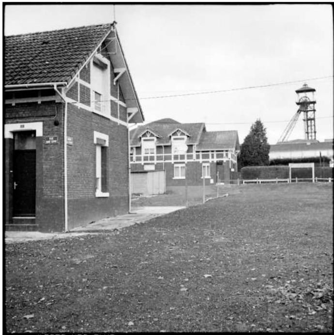
11-19 de Lens.Cité des Provinces.Croisement de la rue du Saint Esprit et de l'avenue de la fosse. En font le puits 11.
